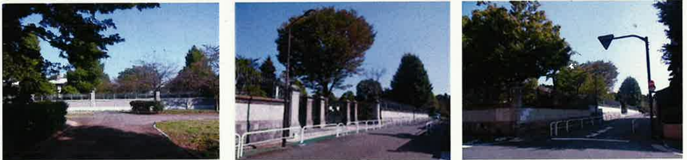
現況写真 (左:跡地内 中央:南門外観 右:外壁外観)
