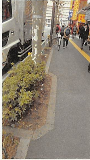
No.22 埋設管障害
