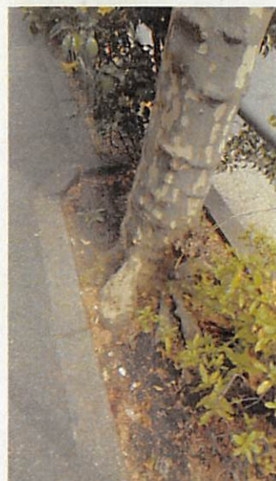
No.6 太根切断可能性大、 掘取穴確保困難
