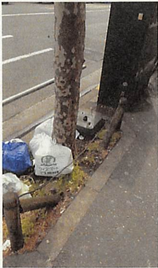
No.16 太根切断の可能性大、埋設管障害
