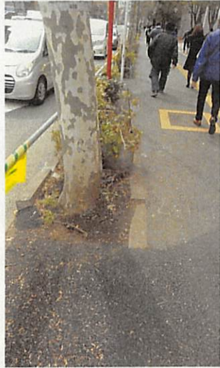
No.10 掘取穴確保困難、埋設管障害
