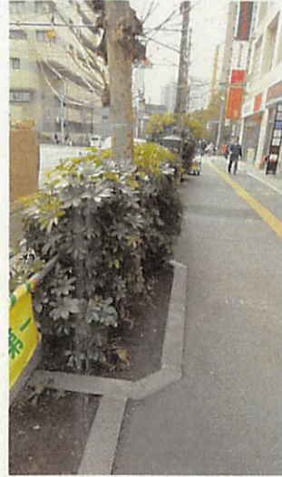
No.12 掘取穴確保困難
