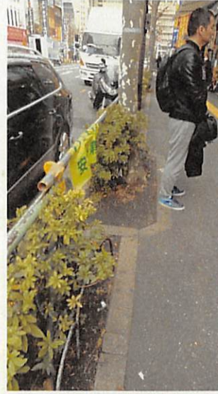
No.23 太根切断可能性大、埋設管障害
