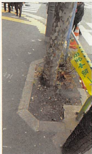
No.33 太根切断可能性大、掘取穴確保困難
