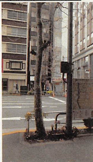
No.1 道路設備に近接・掘取穴確保困難
