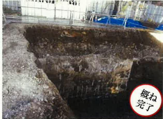
【C】②校舎 アスベスト混入土袋詰め
