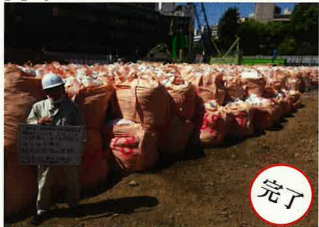
【C】②校舎 アスベスト混入土袋詰め
