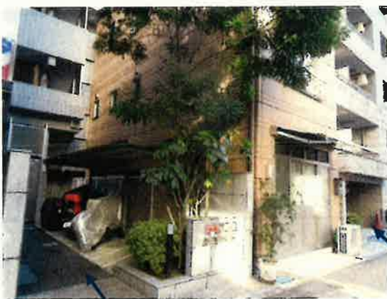
駐輪場・屋外避難階段の出入口
