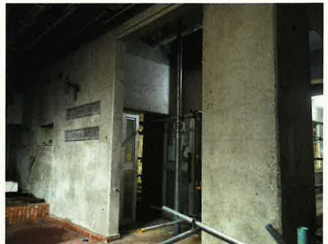
【南棟 B1 階外壁石綿除去後】
