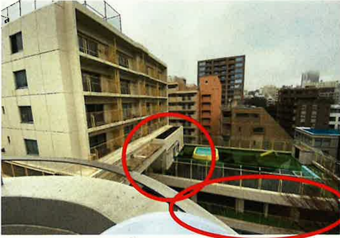
【南棟低層部外壁石綿除去前】
