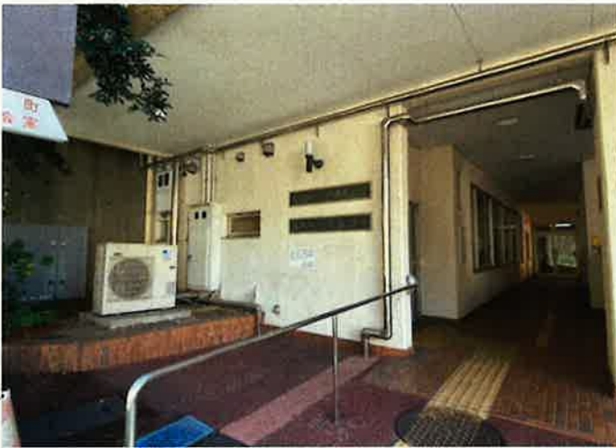
【南棟 B1 階外壁石綿除去前】
