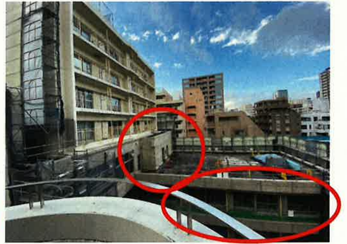
【南棟低層部外壁石綿除去後】
