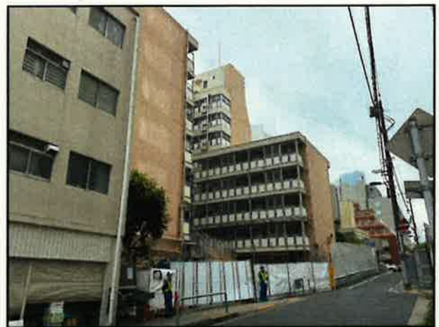
【北棟の状況】 仮囲い設置
