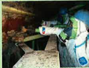
吹付け石綿の除去作業の様子
