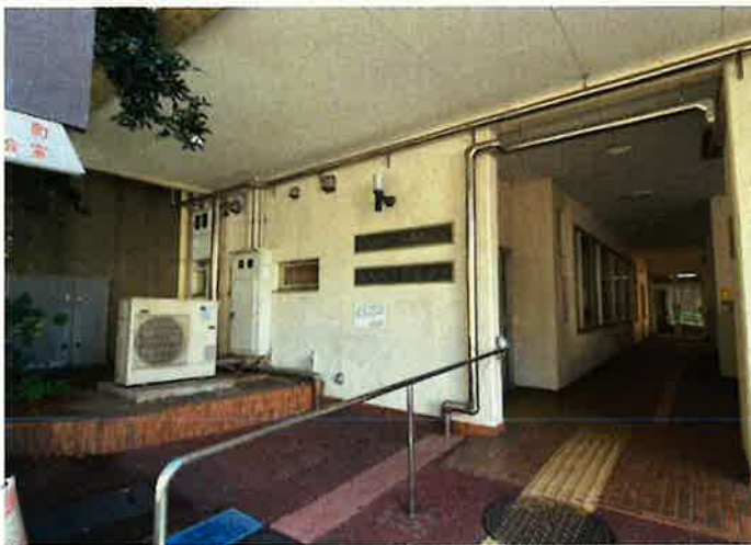
【南棟 B1 階外壁石綿除去前】
