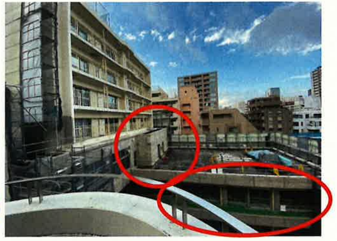
【南棟低層部外壁石綿除去後】
