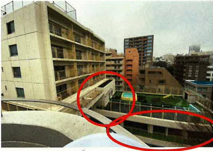
【南棟低層部外壁石綿除去前】
