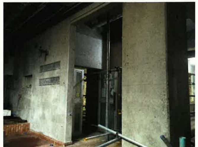
【南棟 B1 階外壁石綿除去後】
