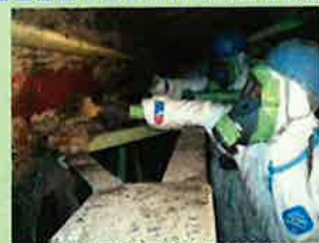
吹付け石綿の除去作業の様子
