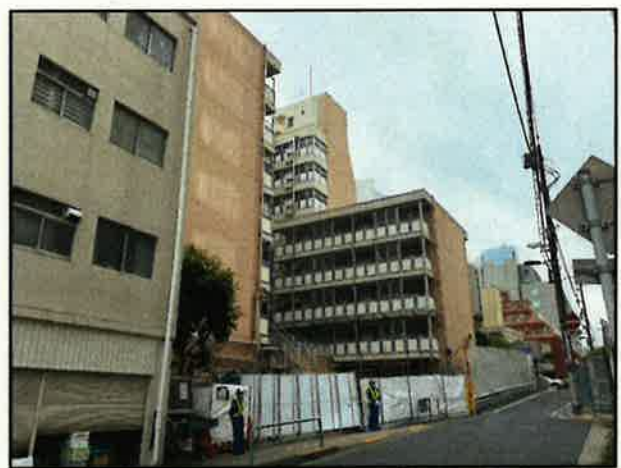
【北棟の状況】 仮囲い設置
