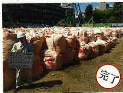
【C】旧錦華小学校 (昭和元年築) アスベスト混入土 袋詰め
