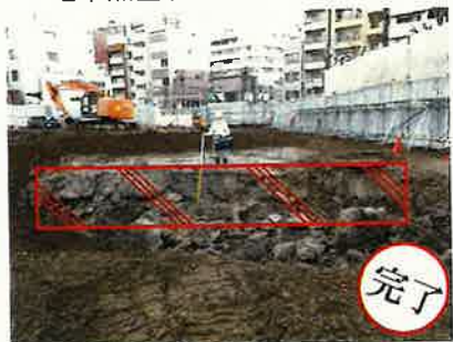
【B】旧錦華小学校 (昭和元年築) 躯体外側
