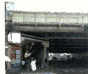
屋根・照明を設置している事例 (錦糸町駅高架下)
