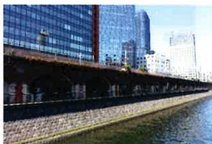
神田川（万世橋の鉄道高架橋）
